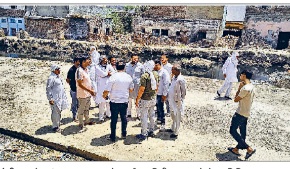
सोनीपत। ड्रेन नंबर 6 पर चल रहे कार्य का निरीक्षण करते मेयर निखिल मदान।
